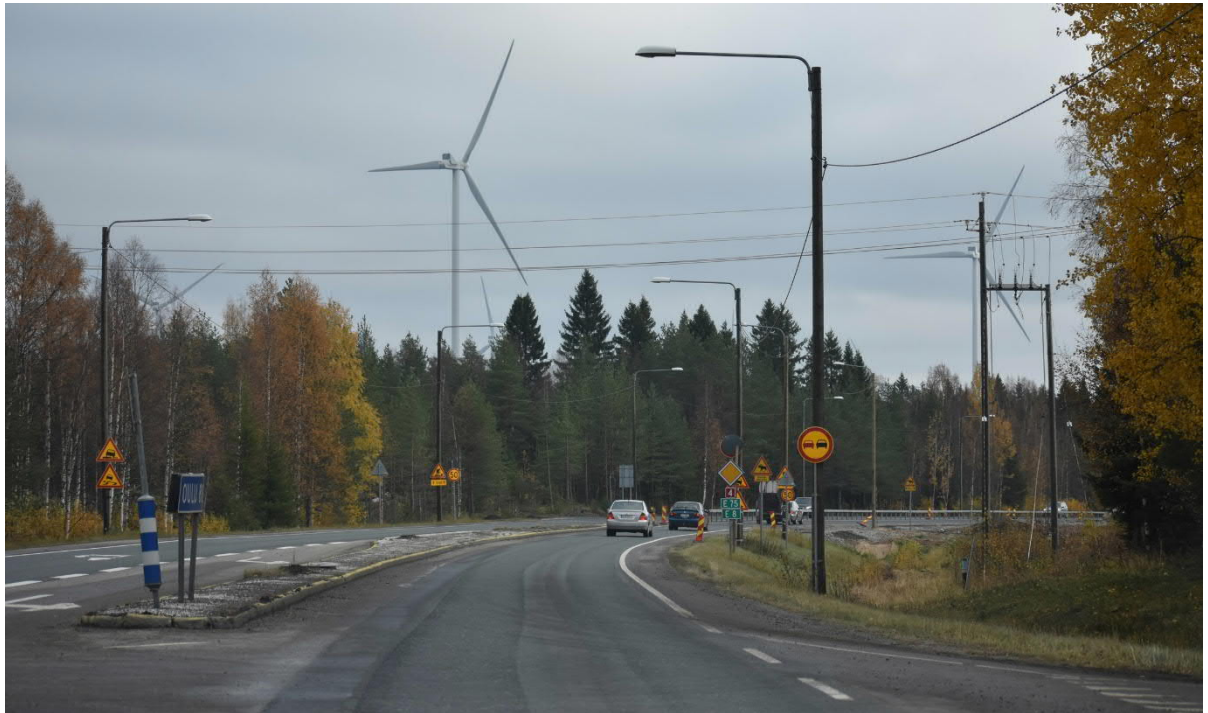
Kuva 8. Vt 4:n tienparannustoimenpiteitä on toteutettu jo Ranuantien risteysen eteläpuolelle saakka.
