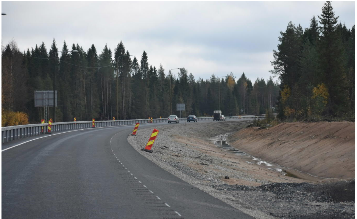
Kuva 9. Tieliuskat on valmiilla tieosuuksilla jo tasoitettu syksyllä 2020
