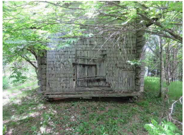
Kuva 8. Kuivas, päreillä vuorattu vanha lato.
