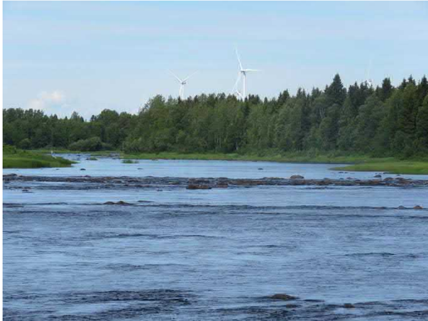
Pohjapato kuvattu pohjoiseen.
