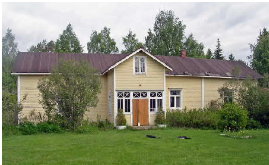
Kuva 33. Lehtolan päärakennus (Kuva LKYT 2006).
