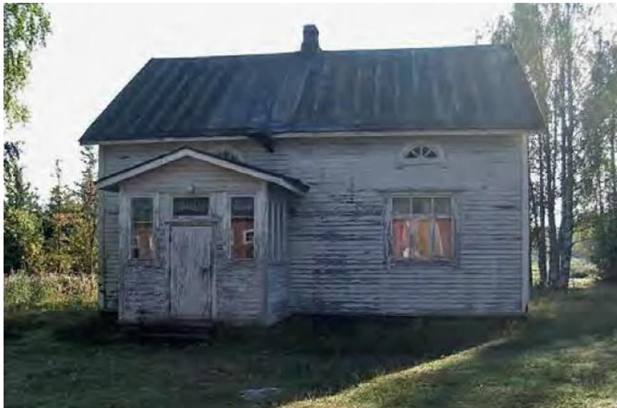
Kuva 14. Lehtolan päärakennus (Kuva LKYT 2006).
