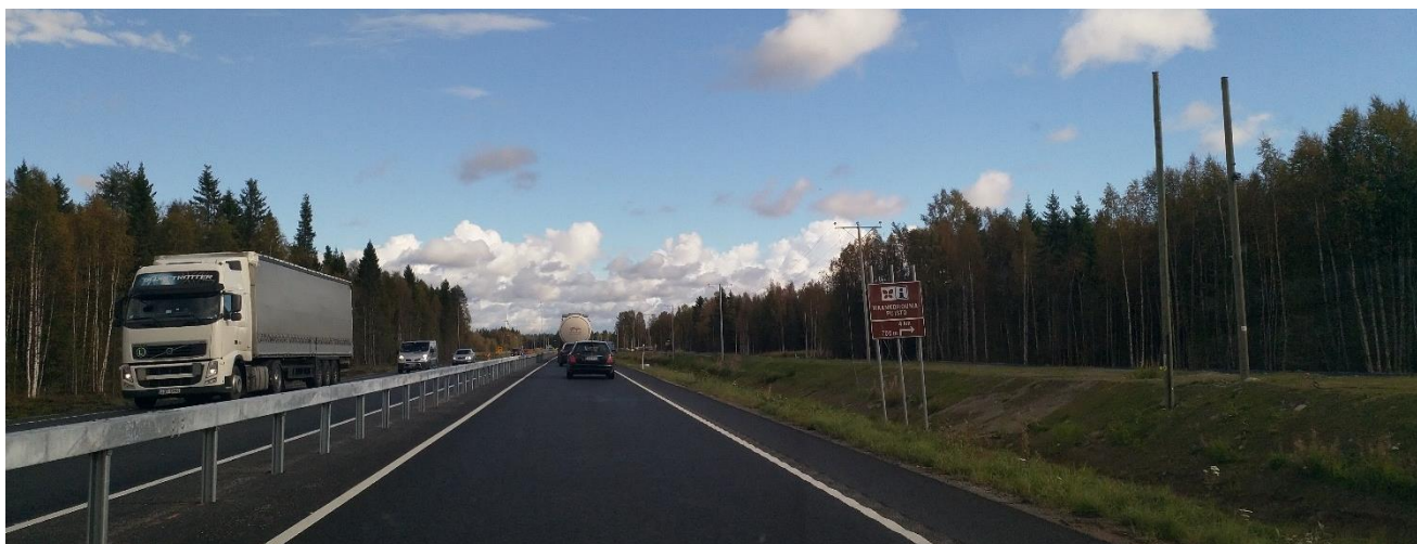
VT4/75 lähestyttäessä Simon taajamaa pohjoisesta.
