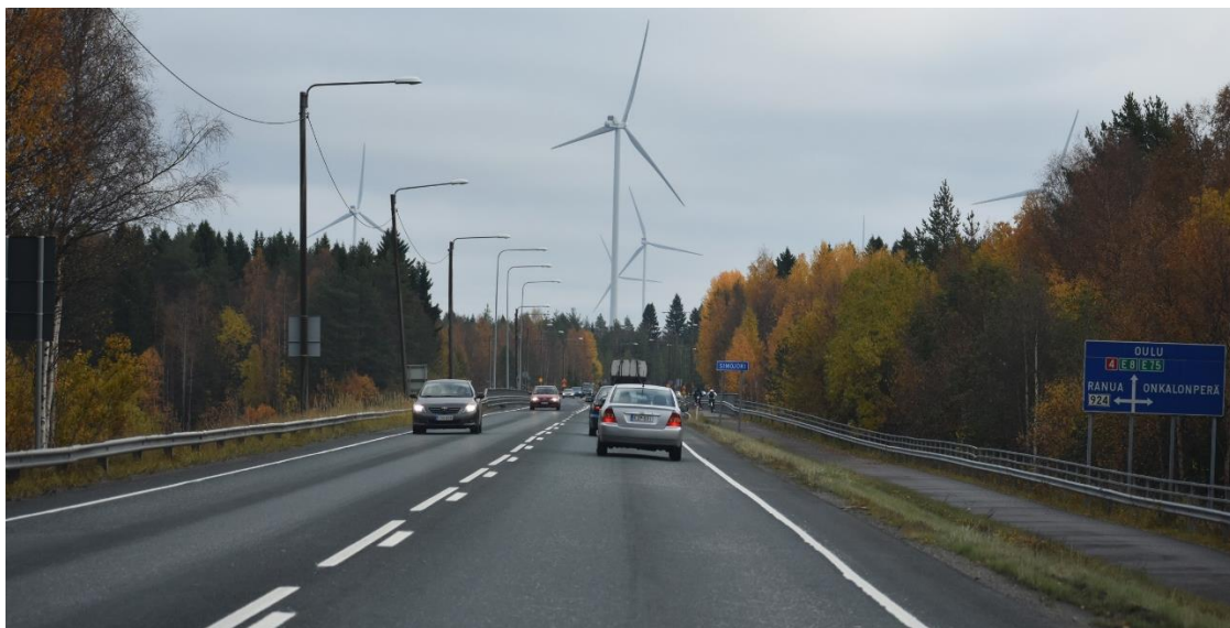
Kuva 19. Vt 4 kaava-alueella ennen Simojoen siltaa (Minna Takalo 2020).
