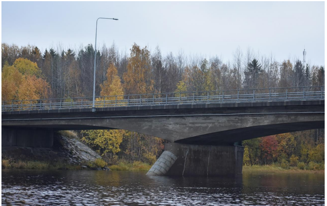
Kuva 16. Simojoen silta (Minna Takalo 2020).
