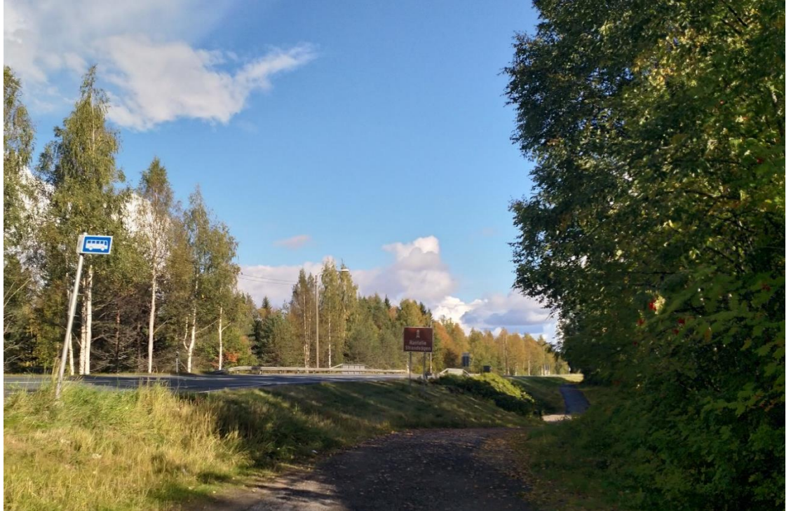
Kuva 10. Pohjoinen kävelyn ja pyöräilyn alikulku pohjoisesta vt4 länsipuolelta.
