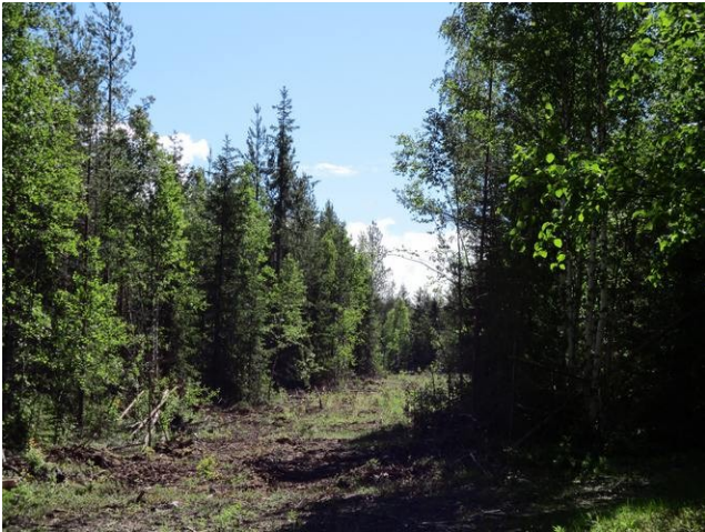
Kuva 3. Tie voimalapaikalle T49 kuvattu kaakkoon. Tasainen rehevätkö kangas.
