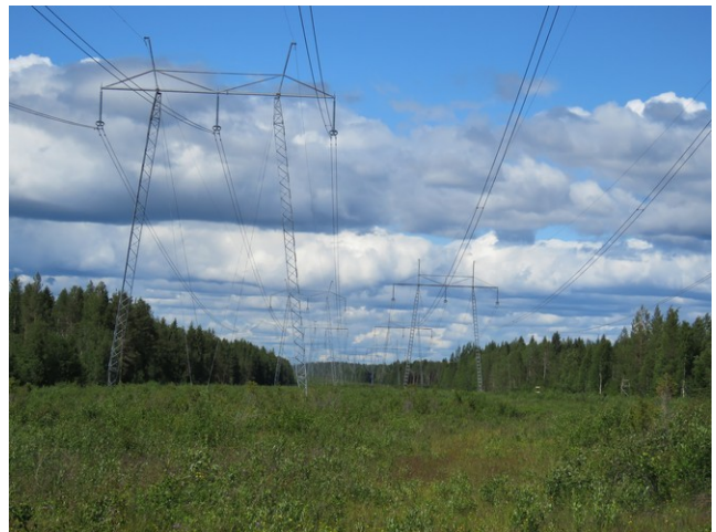
Kuva 62. Voimalinja kuvattu Kotasuolta etelään.
