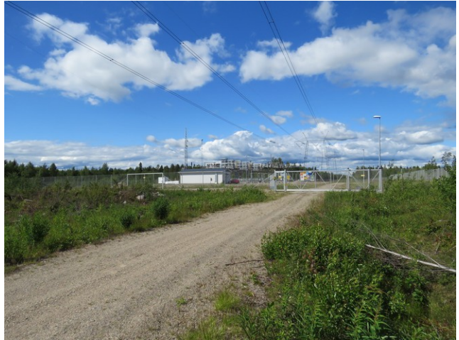
Kuva 64. Raatokankaan sähköasema kuvattu pohjoiseen.
