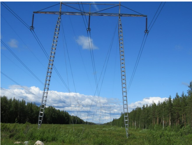
Kuva 59. Voimalinja kuvattu Kärppäojasta etelään. Tasainen pohjareenialue, laajalti soistunut.
