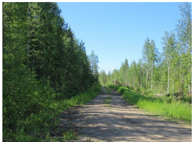
Kuva 48. Tie voimalapaikalle T63 kuvattu kaakkoon.
