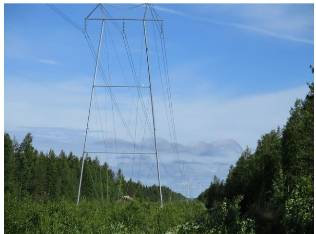
Kuva 18. Läntinen voimalinja Muhojoen kohdalla kuvattu pohjoiseen.
