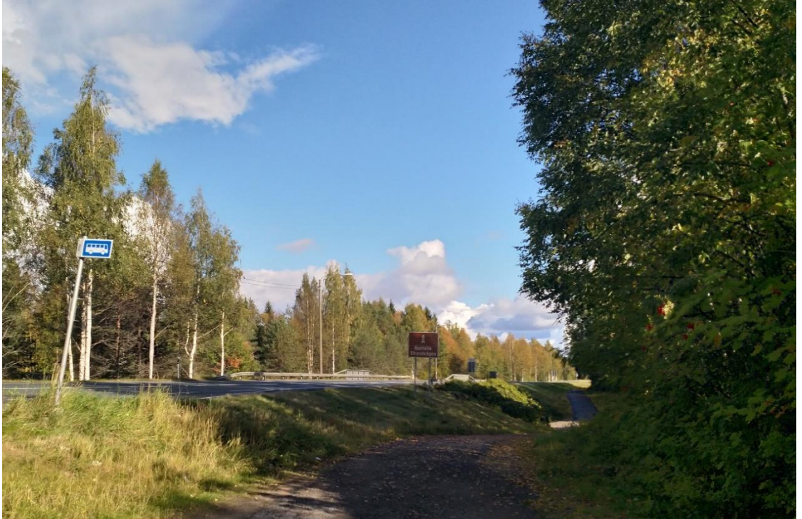
Kuva 12. Pohjoinen kävelyn ja pyöräilyn alikulku pohjoisesta vt4 länsipuolelta.
