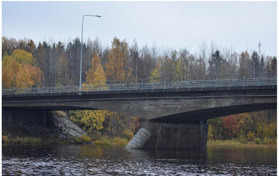
Kuva 18. Simojoen silta (Minna Takalo 2020).
