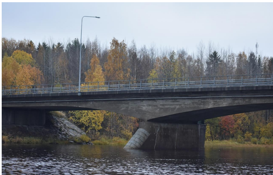
Kuva 19. Simojoen silta (Minna Takalo 2020).
