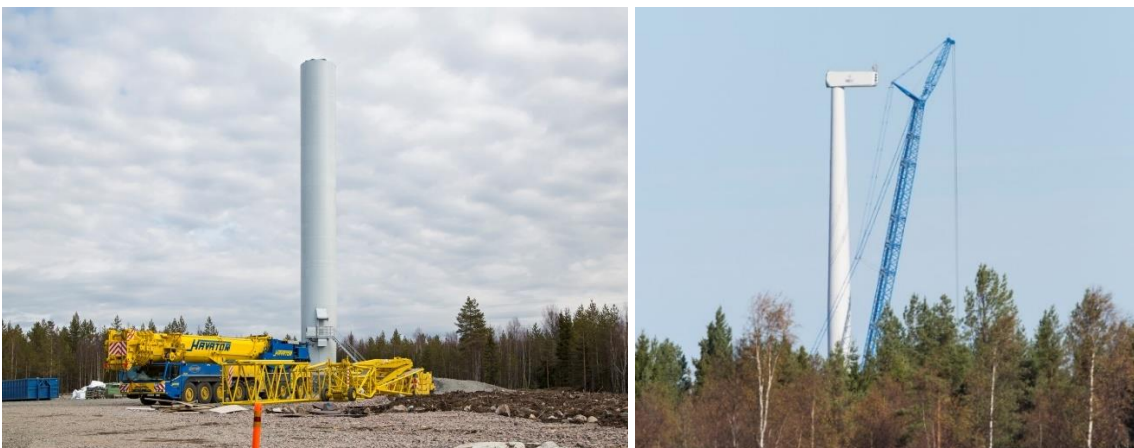
Kuva 20. Tuulivoimalan kokoamista. (Kuvat: Ville Suorsa, FCG)
