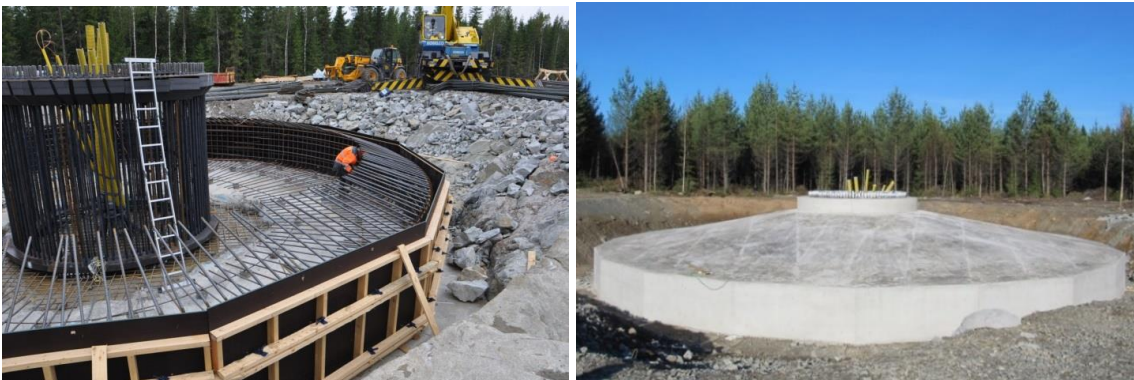
Kuva 19. Tuulivoimalan perustusten rakentamista. (Kuvat: Leila Väyrynen, FCG)
