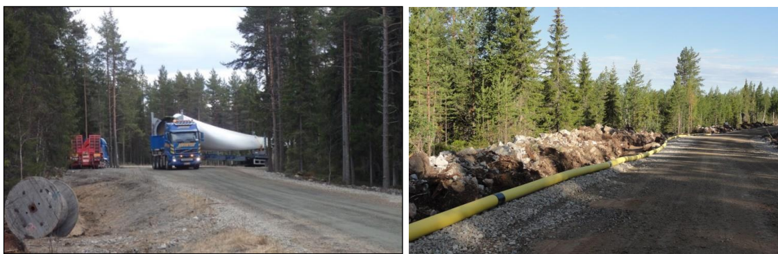
Kuva 15. (Vasemmalla) Esimerkki tuulivoimapuiston rakennus- ja huoltotiestä rakentamisaikana. Teitä käytetään muun muassa betonin, soran ja voimaloiden komponenttien kuljetuksiin sekä tuulivoimapuiston käyttövaiheessa huoltoajoihin. Maakaapeli sijoitetaan ojakaivantoon tien reuna-alueelle. (Oikealla) Tuulivoimalan osia kuljetetaan erikoiskuljetuksina. (Kuvat: Ville Suorsa / FCG).
