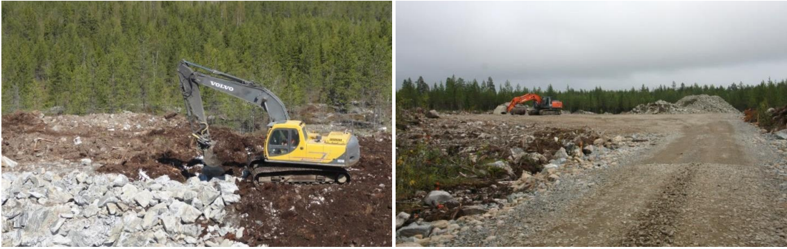
Kuva 17. Tuulivoimapuiston rakentaminen alkaa huoltoteiden ja pystytysalueiden rakentamisella (kuvat: Ville Suorsa, FCG).
