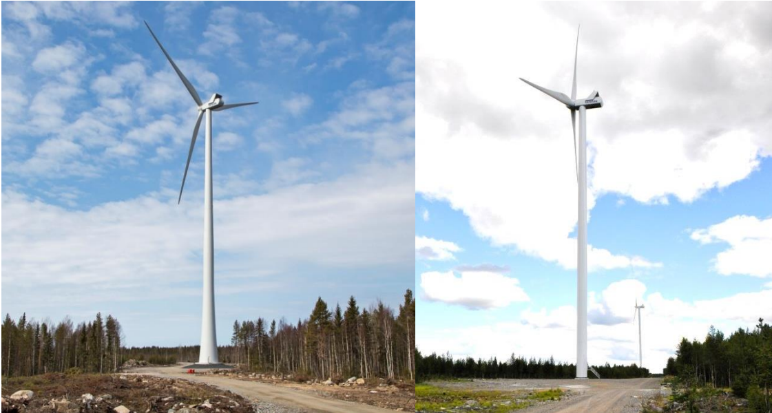
Kuva 11. Vasemmalla on esimerkki teräslieriötornista ja oikealla hybriditornista. (Kuvat: Leila Väyrynen ja Ville Suorsa, FCG)
