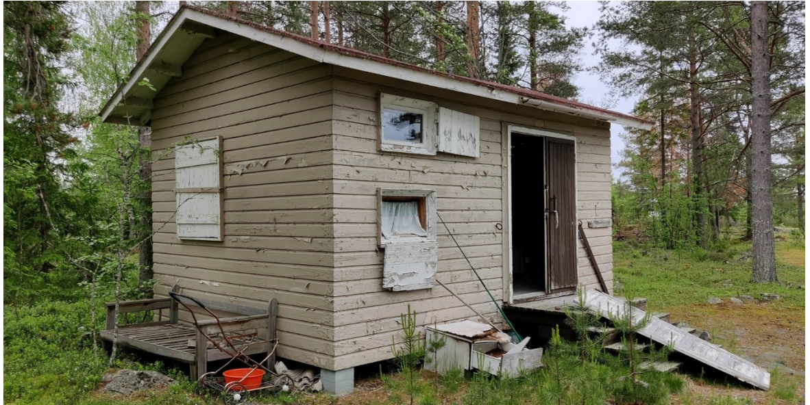
Kuva 13. Asemakaava-alueella sijaitseva purkukuntoinen lomarakennus. Kuva: Minna Takalo 28.06.2021.
