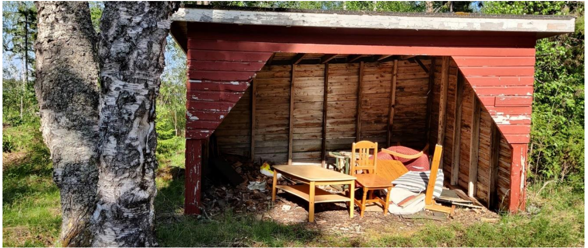
Kuva 6. Asemakaava-alueella sijaitseva katos. Kuva: Minna Takalo 28.06.2021.
