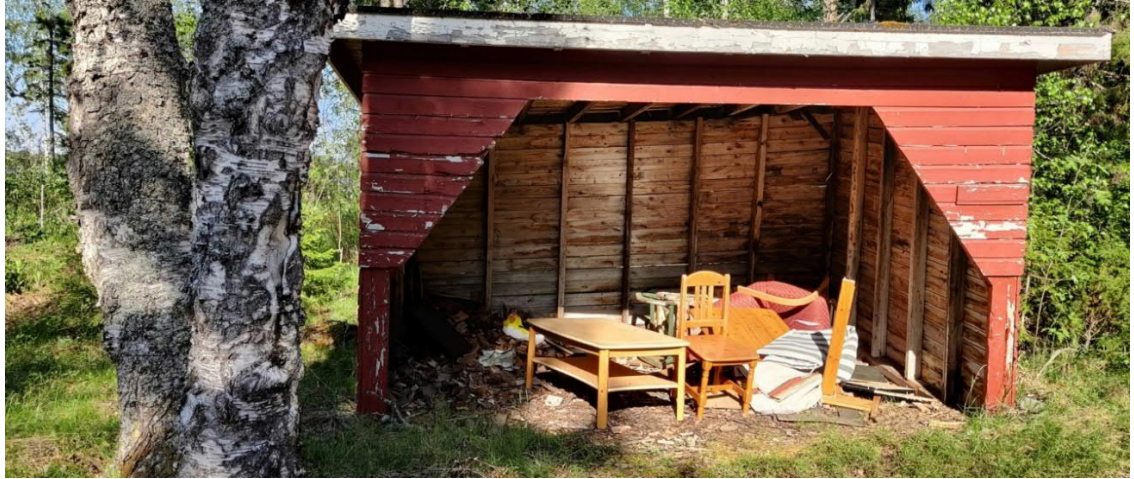
Kuva 6. Asemakaava-alueella sijaitseva katos. Kuva: Minna Takalo 28.06.2021.
