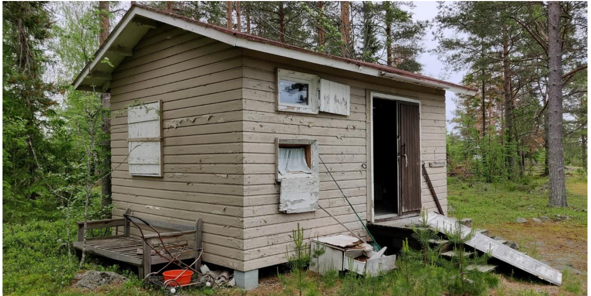
Kuva 4. Asemakaava-alueella sijaitseva lomarakennus. Kuva: Minna Takalo 28.06.2021.
