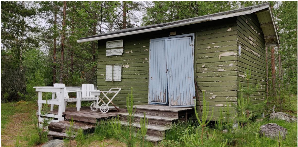
Kuva 5. Asemakaava-alueella sijaitseva lomarakennus. Kuva: Minna Takalo 28.06.2021.
