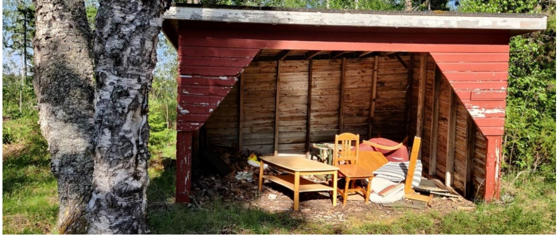
Kuva 6. Asemakaava-alueella sijaitseva katos. Kuva: Minna Takalo 28.06.2021.
