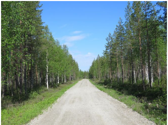
Kuva 8. Kunnostettu metsäautotie Perämaan kohdalla.
