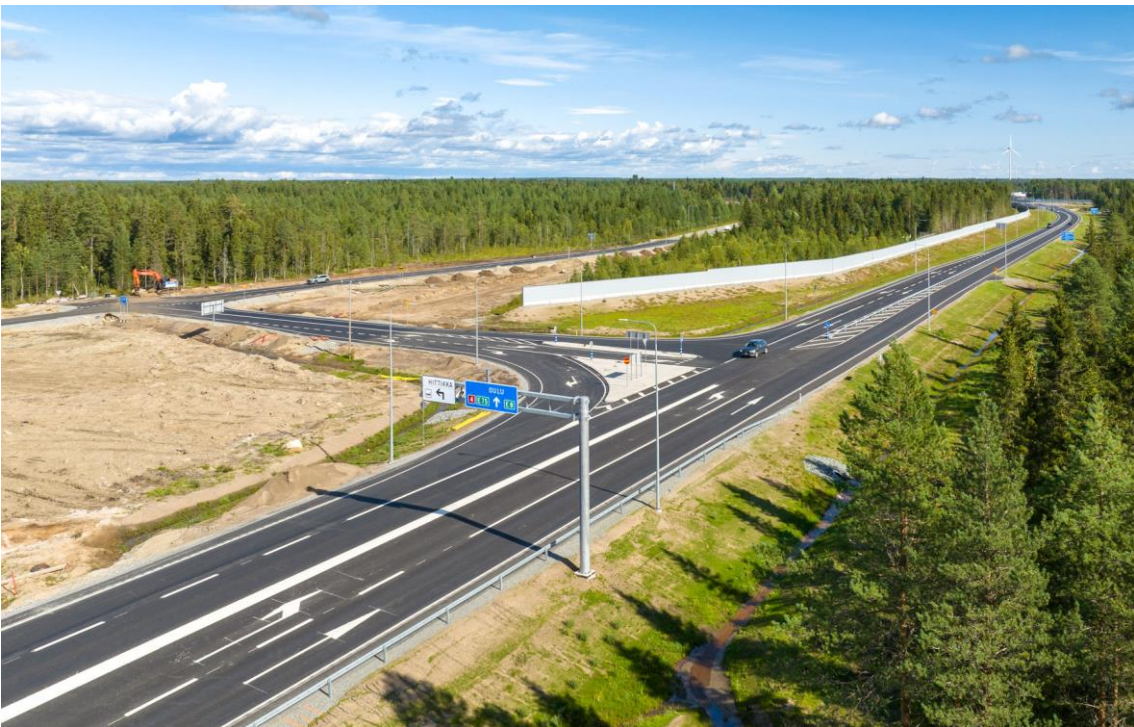
Kuva 17. Risteysalueen meluntorjuntaseinämästä. © Simon kunta 2023.
